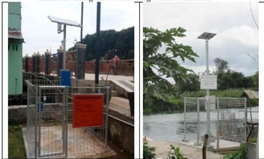
Gambar 61. Contoh Detail Bangunan Pelindung Permanen Pilihan 2. Bangunan Pelindung Tidak Permanen
