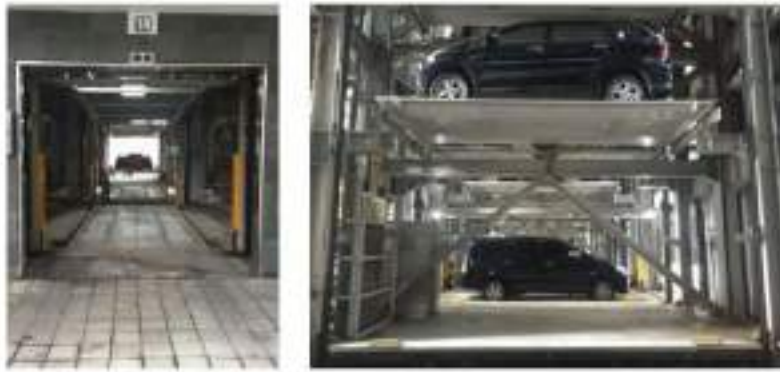
Gambar II.271 Contoh penerapan sistem parkir mobil otomatis
