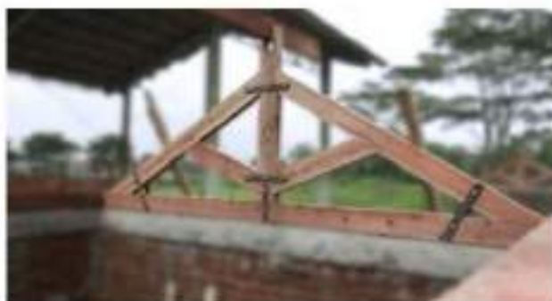
Gambar II.387 Kuda-kuda Kayu Dengan Pengikat Plat Baja
