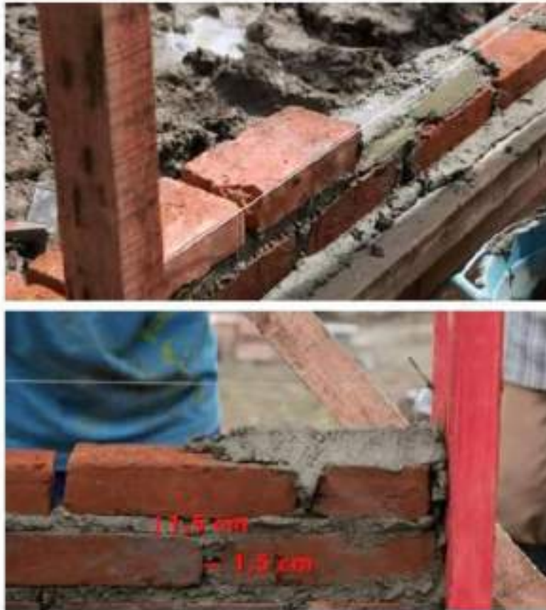
Gambar II.400 Proses Pemasangan Batu Bata Untuk Dinding
