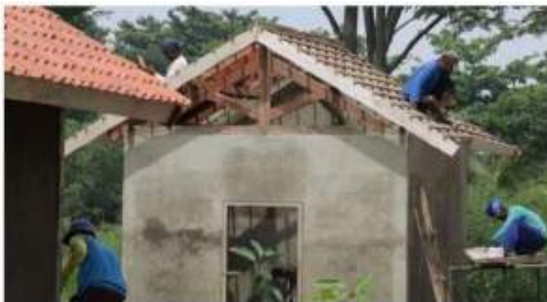
Gambar II.386 Kuda-kuda Kayu Pada Atap Rumah Tinggal
