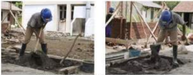
Gambar II.367 Proses Pencampuran Mortar
