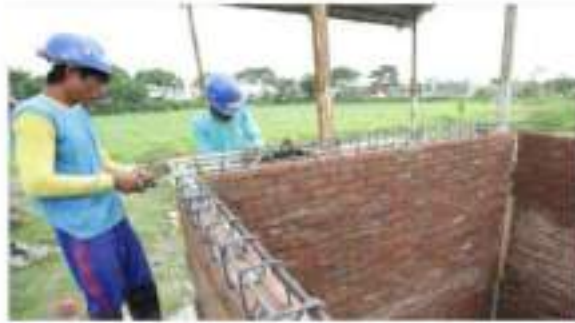
Tulangan balok keliling/ring dirangkai di atas dinding
