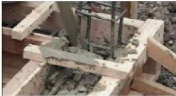
Gambar II.418 Pengecoran Balok Pengikat/ Stoof
