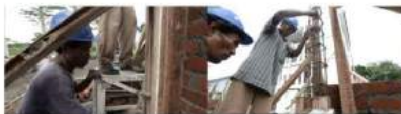
Gambar II.416 Pemasangan Beton Dengan Memukul-mukul Cetakan/ Bekisting dan Campuran Beton Dirojok Menggunakan Besi atau Bambu
