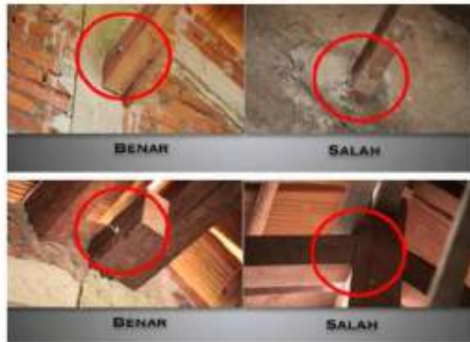
Gambar IL.397 Contoh Detail Pertemuan Antara Ikatan Angin dengan Gunung-Gunung/ Angpig
