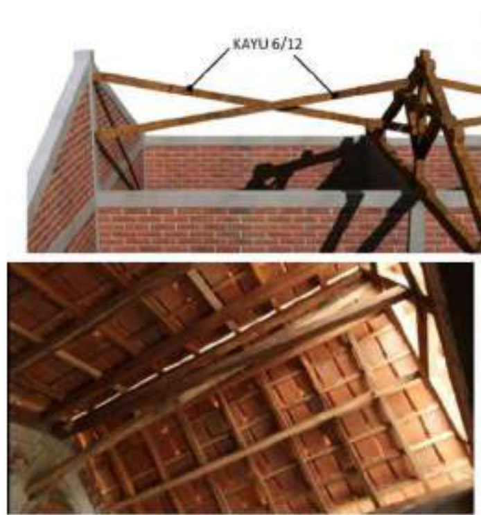
Gambar II.395 Ikatan Angin Antara Kuda-Kuda Kayu dengan Gunung-Gunung/ Angig
