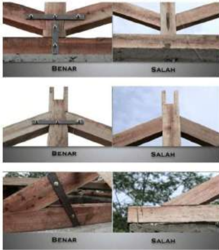
Gambar II.388 Pemasangan Plat Baja Pada Kuda-kuda Kayu
