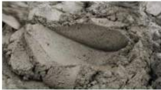
Gambar II.368 Hasil Pencampuran Mortar Yang Baik
