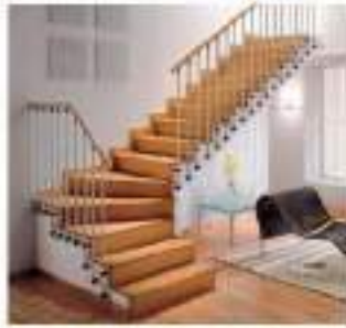
Gambar II.128. Contoh penerapan tangga kipas
