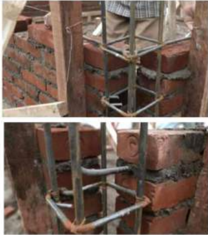
Gambar II.406 Pemasangan Angkur Besi Sebagai Pengikat Antara Kolom dengan Dinding Pada Sudut Bangunan
