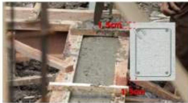
Gambar II.378 Balok Pengikat/ Sloof
