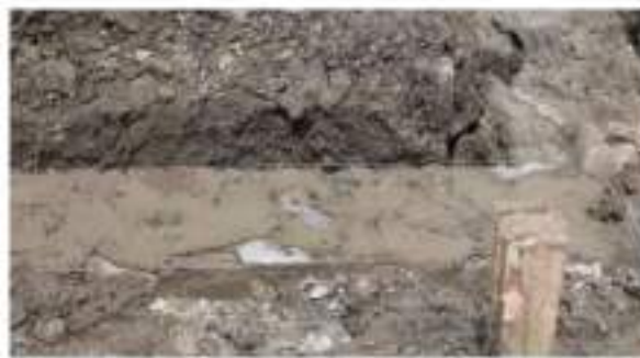
Gambar II.370 Pondasi Dari Batu Kali/Gunung
