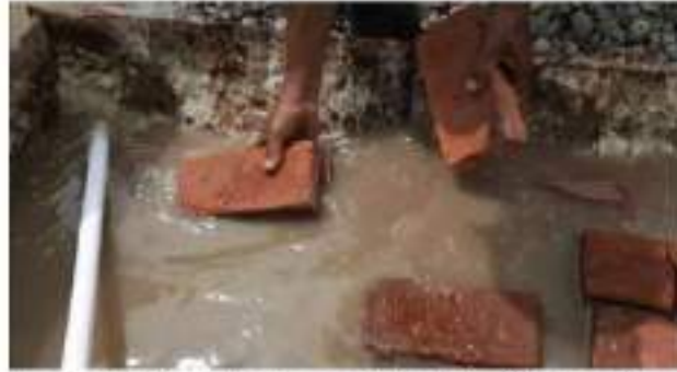
Gambar II.374 Perendaman Batu Bata Sebelum Dipasang.
