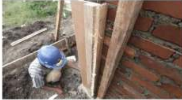
Gambar II.414 Pemasangan Cetakan/ Bekisting Untuk Kolom
